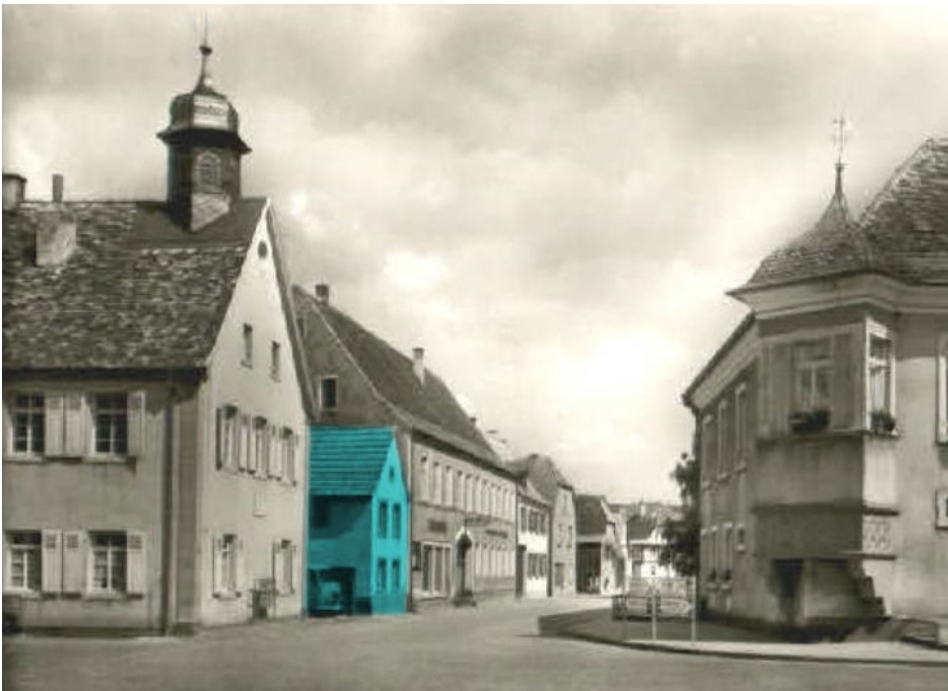
Haus Nr. 7, ehemaliges Wohnhaus von Georg Wendel
