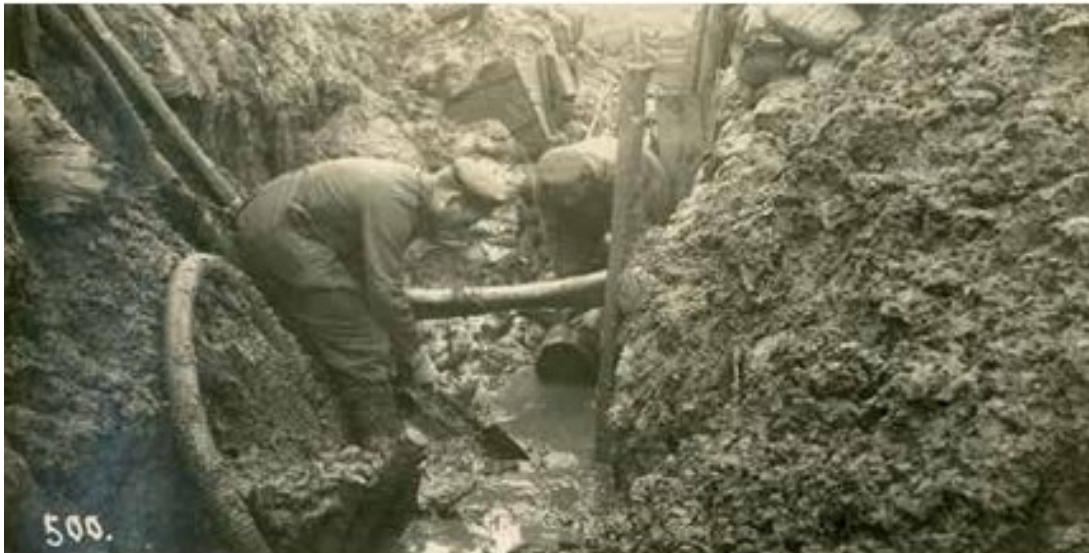
Abb. 15: Schützengraben nach Starkregen
