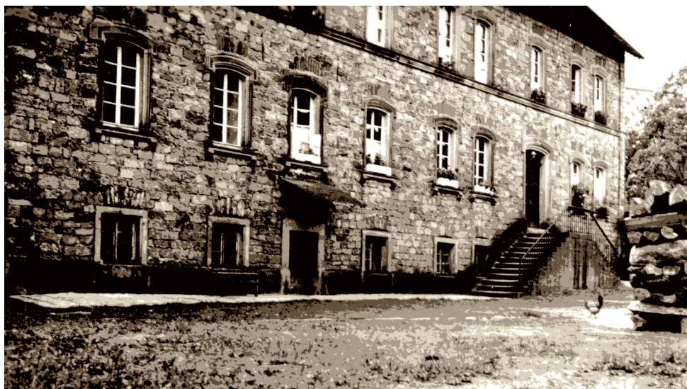
Innenhof vor Umbau
