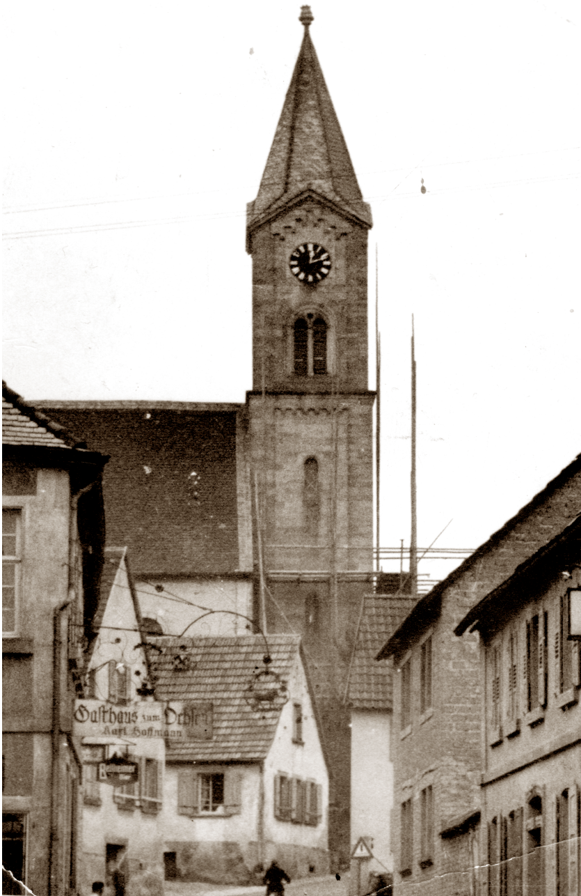
Die evangelische Kirche zu Klingenstein im Jahr 1953, beim Abriss des Turms
