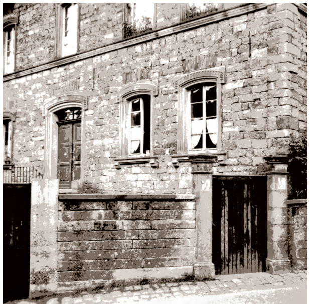
Eingangsbereich altes Gebäude
