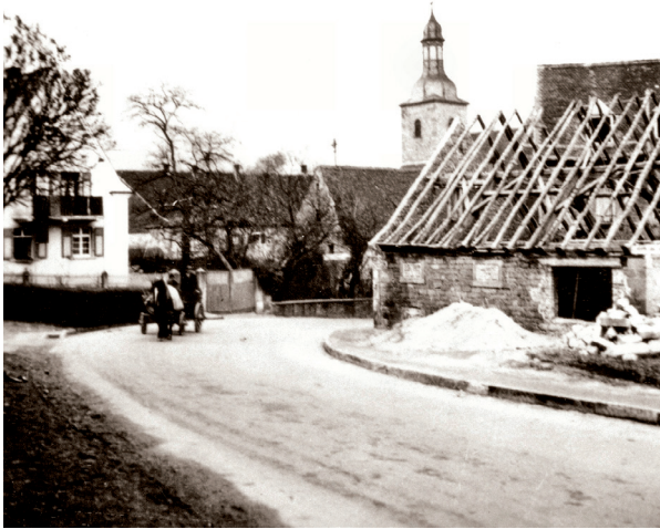
Nebengebäude beim Umbau 1953
