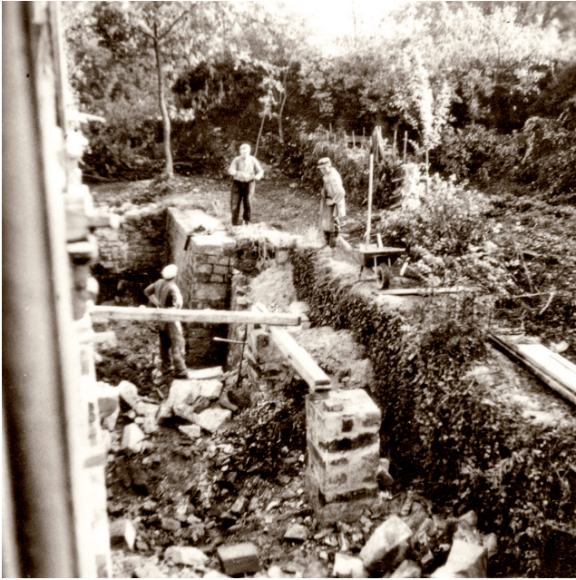
Abbau der äußeren Mühleinrichtungen, Mühlrad und Lager wurden entfernt, das „Wasserhaus“ mit Bauschutt aufgefüllt.
